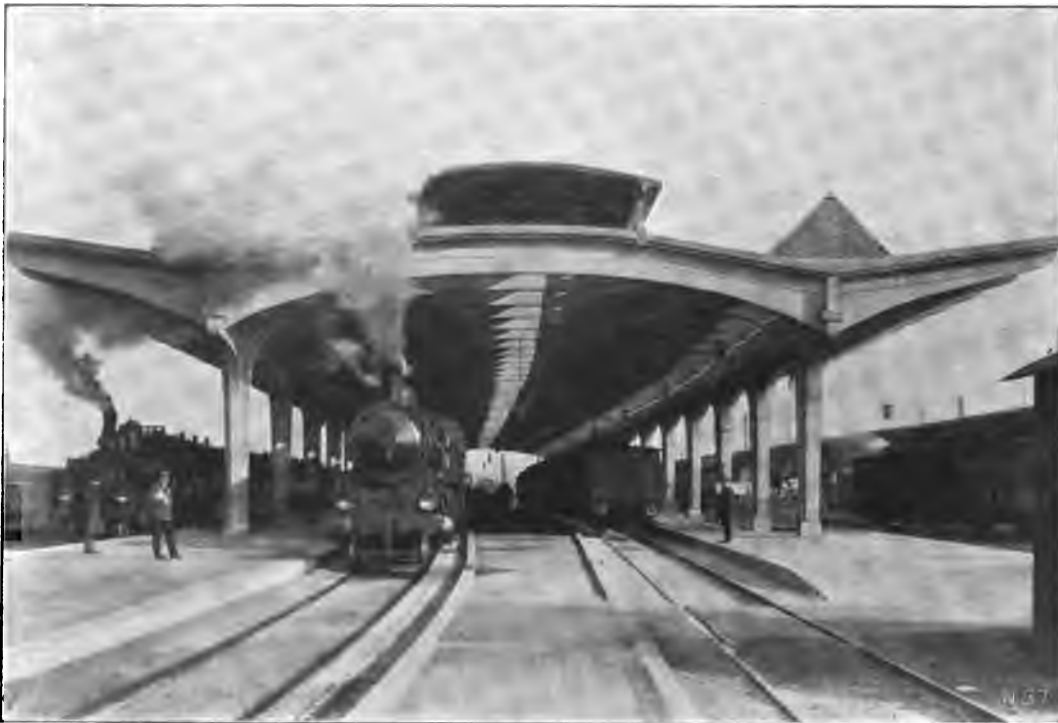
Abb. 97. Zweistielige Bahnsteighalle in Nürnberg.
